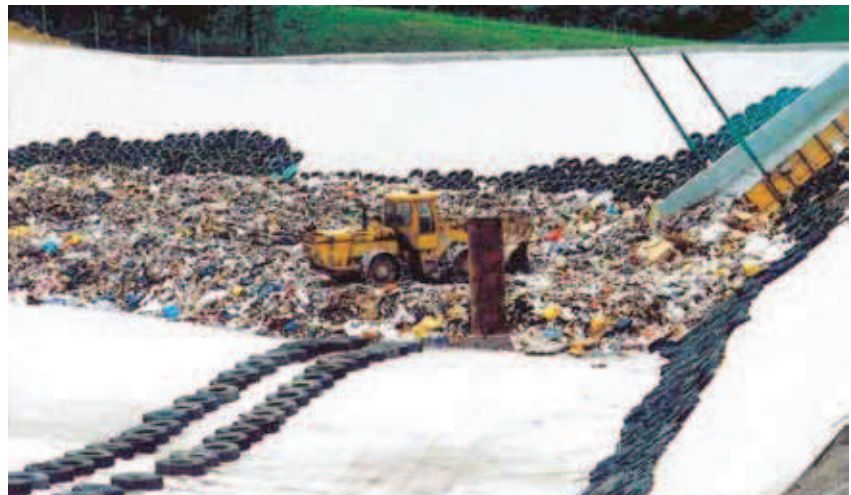
Enviromat® digunakan pada TPA untuk mencegah limbah cair beracun masuk ke dalam tanah
