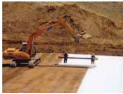
Penggelaran Enviromat® di lapangan menggunakan crane
