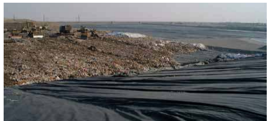
Mirafi® FW adalah pilihan tepat untuk sistem lapisan penutup pada tempat pembuangan sampah akhir.
