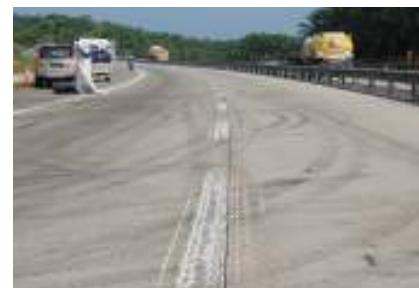
Lembaran strip Polyfelt® PGM-G sangat sesuai untuk pemasangan di atas retakan pada perkerasan jalan dengan aspal (kiri) dan di atas sambungan perkerasan jalan dengan beton (kanan).
