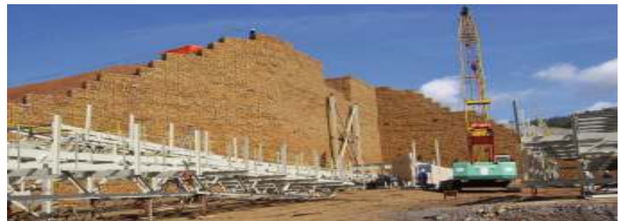
Gambar 4: Contoh tipikal dinding yang diperkuat Polyfelt® PEC yang sudah selesai
