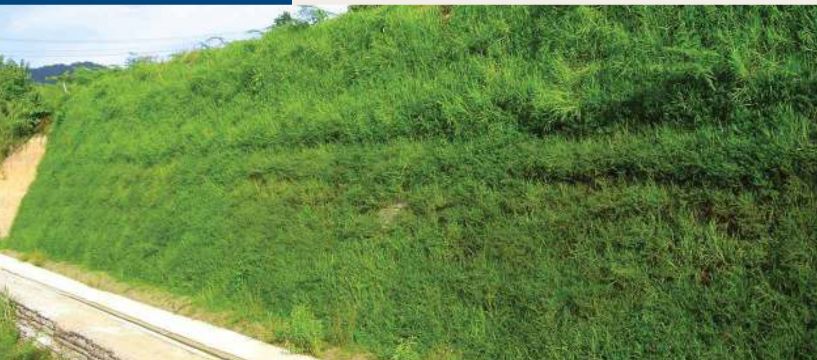
Lereng tanah ber-perkuatan dan bervegetasi menggunakan Polyfelt® Polymat EM.
