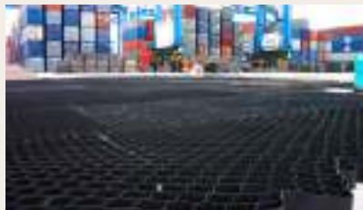
TenCate Polyfelt® Envirocell meningkatkan kapasitas daya dukung tanah dasar.
