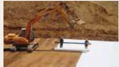
Penggelaran Polyfelt® Enviromat GCL dengan ekskavator
