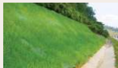
Lereng tanah ber-perkuatan dan bervegetasi menggunakan Polyfelt® Polymat EM.
