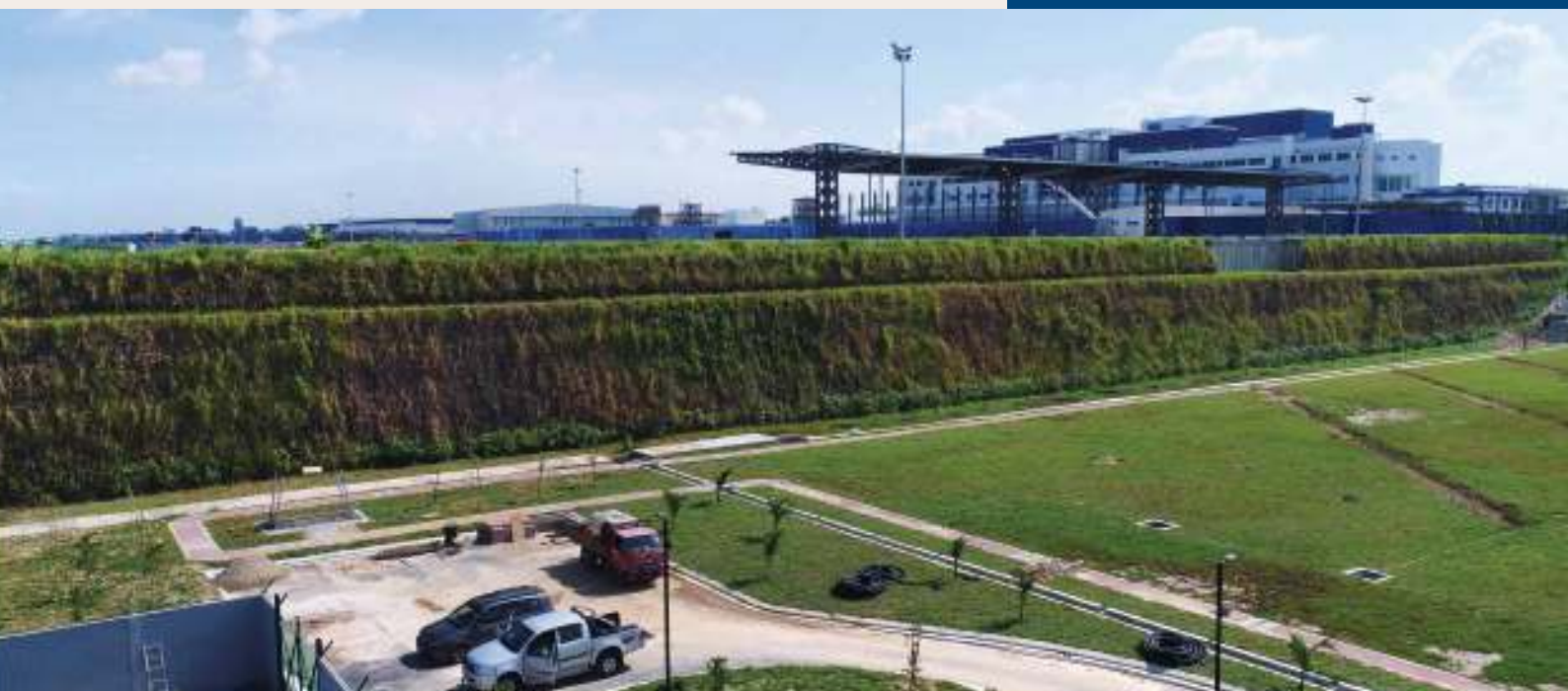
TenCate Polyfelt® Envirofelt dihamparkan diatas struktur perkuatan tanah pada lereng.
