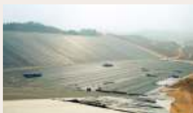
Pemasangan Mirafi® FW di TPA Sampah.
