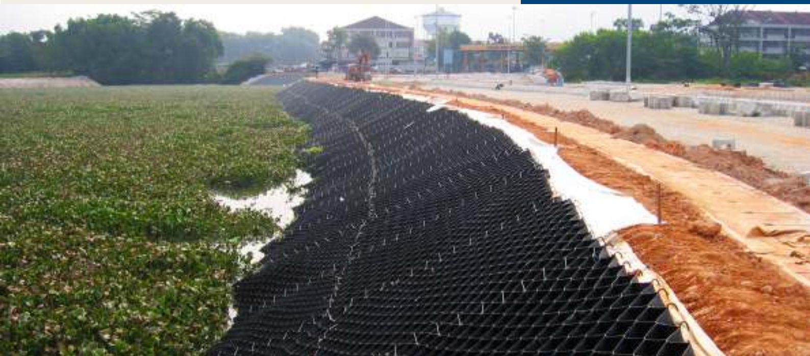
TenCate Polyfelt® Envirocell meningkatkan kapasitas daya dukung tanah dasar.
