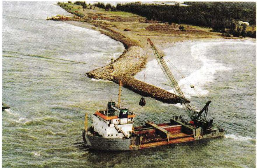
Konstruksi pemecah gelombang.
