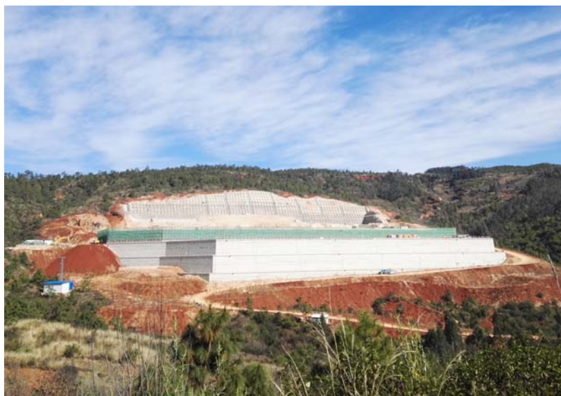
> 图3. 竣工的土挡墙的全景图。
