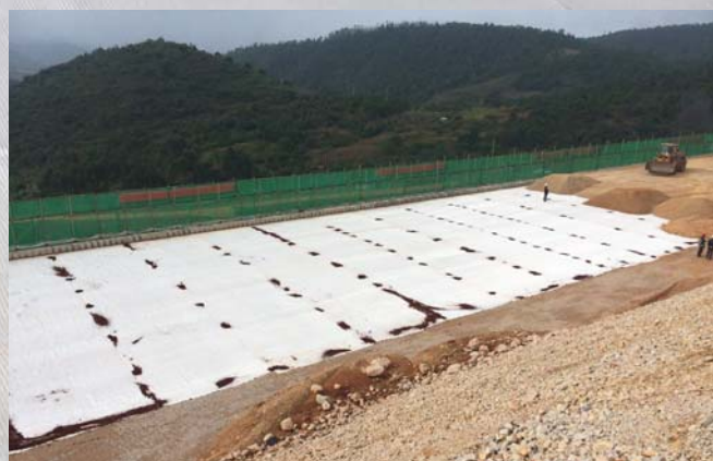
> 图4d. 加筋网上覆土。
