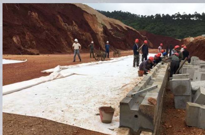
> 图4b. 加筋网固定在上下层模块之间。
