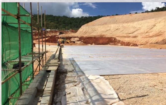
> 图4c. 加筋网在面墙固定后拉伸张紧。
