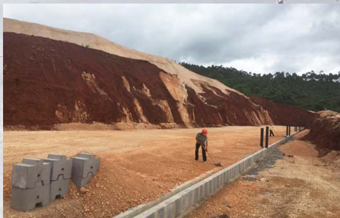
> 图4a. 铺完基块后的准备工作。
