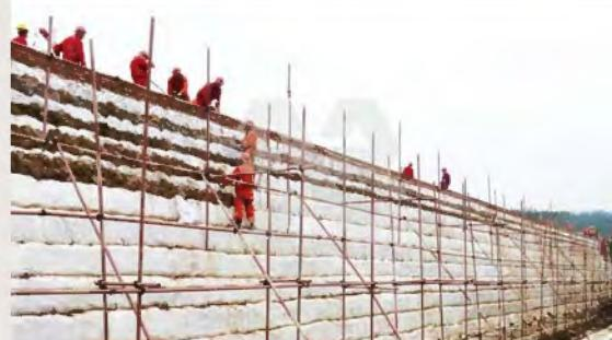
这个面板系统适用于边坡角度在80°以内，坡高从3米到50米之间的边坡。在填土后面修建用土工合成材料包裹碎石组成的砾石积水层用来收集墙后渗水，然后通过排水管道排到墙体外面。这个完整的结构在种植植物之后，很容易与周围环境相适应。它是一个可靠并且性价比很高的用来代替混凝土结构的不错选择之一。
