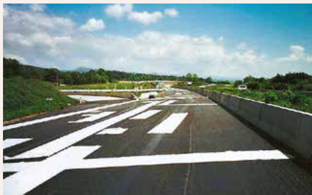
使用TenCate Polyfelt® PGM-G对高速公路进行局部处理
