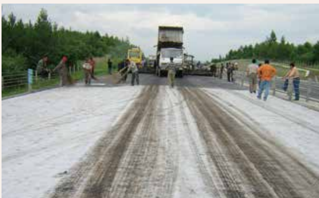
使用TenCate Polyfelt® PGM 14对高速公路全面加铺
