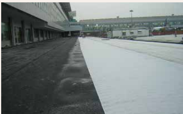
使用TenCate Polyfelt® PGM 14铺设机场停机坪
