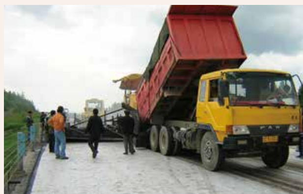
在TenCate Polyfelt® PGM上铺设面层
