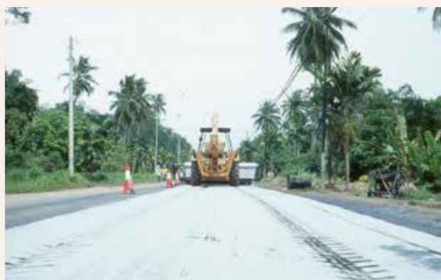
铺设TenCate Polyfelt® PGM后的施工现场
